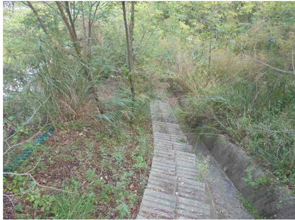
산마루측구, 점검계단 전경
