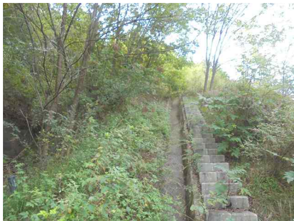
산마루측구, 점검계단 전경
